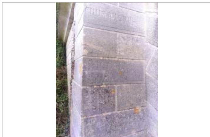
Vue du repère - Auteur : SPC LACI
