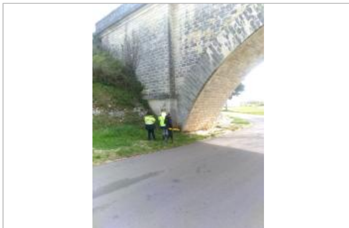
Vue du site - Auteur : SPC LACI
