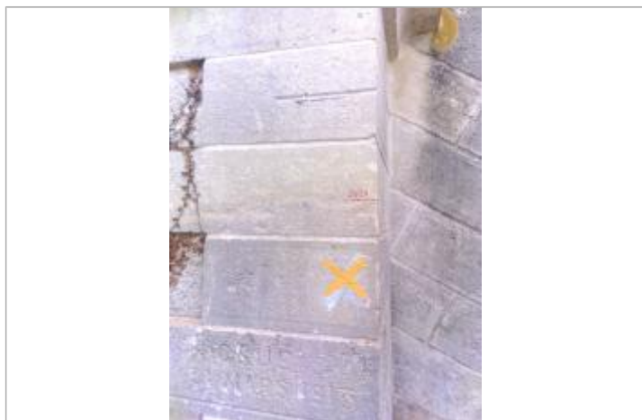
Vue du repère - Auteur : SPC LACI
