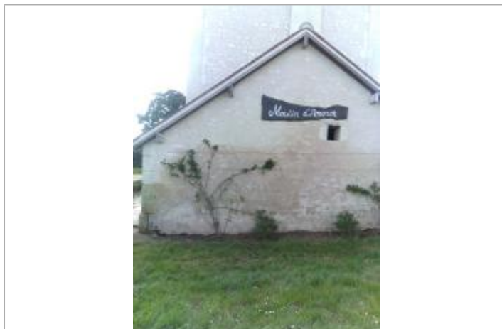
Vue du site - Auteur : SPC LACI
