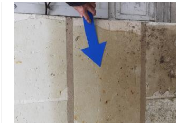
Vue de la laisse - Auteur : SPC MLA
