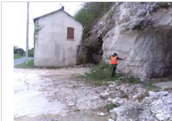
Vue du site - Auteur : SPC LACI
