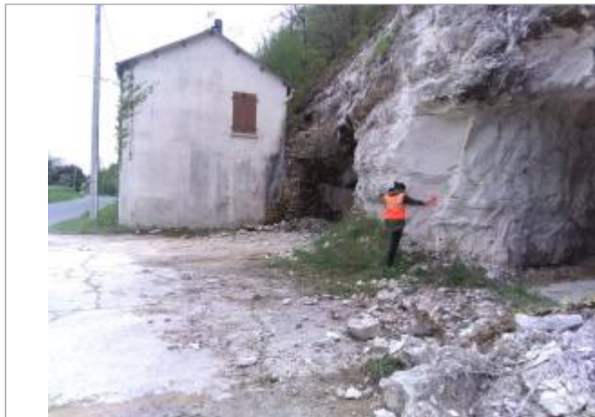
Vue du site - Auteur : SPC LACI
