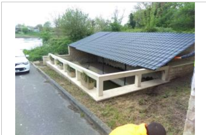
Vue du site - Auteur : SPC LACI
