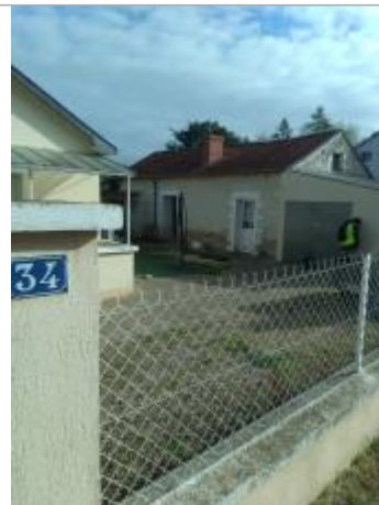
Vue du site - Auteur : SPC LACI
