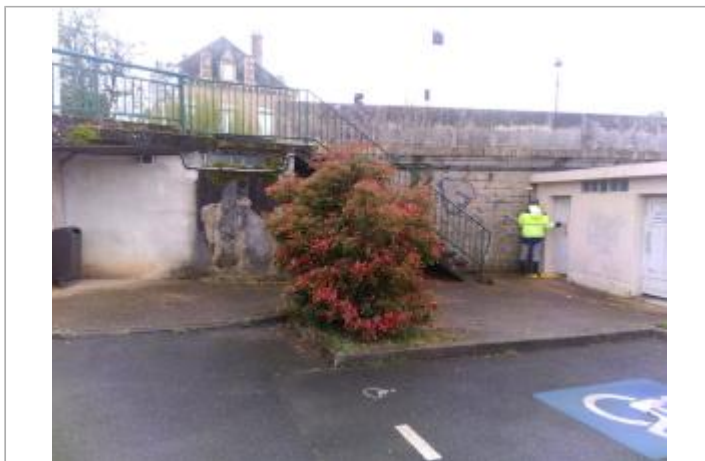
Vue du site - Auteur : SPC LACI
