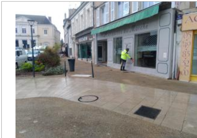
Vue du site - Auteur : SPC LACI
