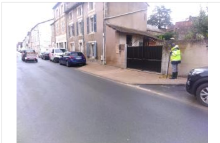
Vue du site - Auteur : SPC LACI
