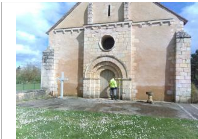
Vue du site - Auteur : SPC LACI
