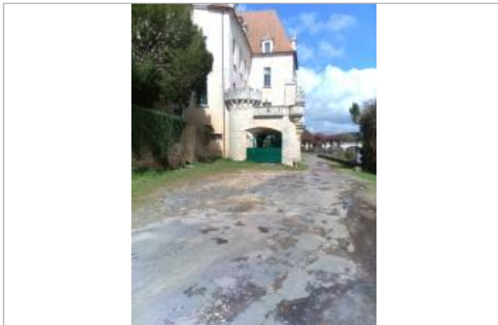
Vue du site - Auteur : SPC LACI
