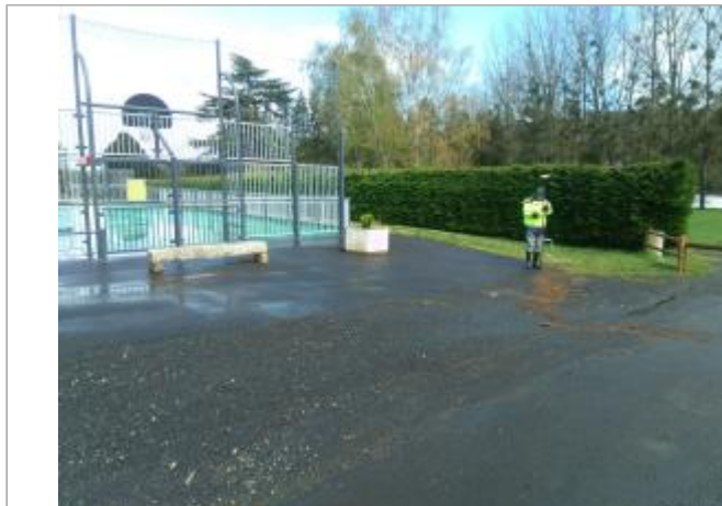
Vue du site - Auteur : SPC LACI
