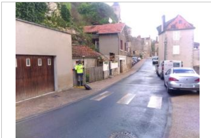
Vue du site - Auteur : SPC LACI
