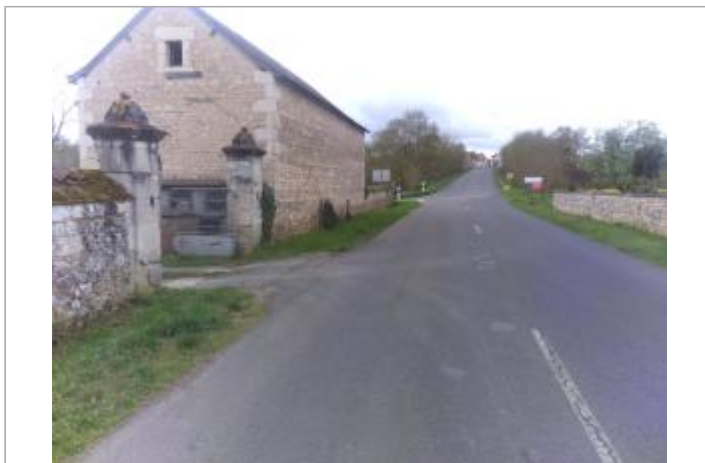
Vue du site - Auteur : SPC LACI
