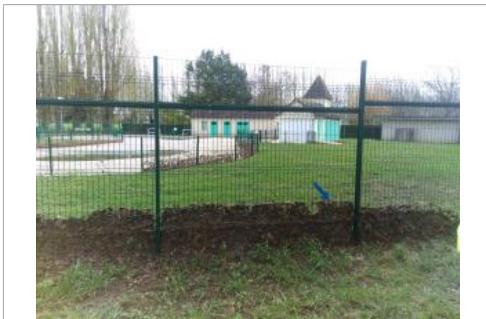
Vue du site - Auteur : SPC LACI
