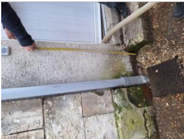
Vue de la laisse - Auteur : SPC MLA
