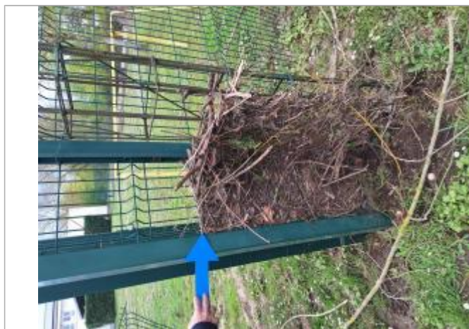
Vue de la laisse - Auteur : SPC MLA
