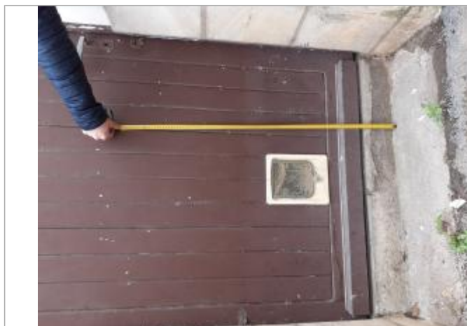
Vue de la laisse - Auteur : SPC MLA
