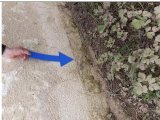
Vue de la laisse - Auteur : SPC MLA
