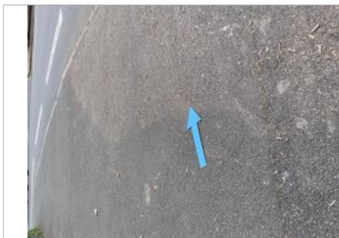
Vue de la laisse - Auteur : SPC MLA
