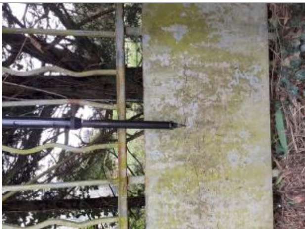
Vue de la laisse - Auteur : SPC MLA
