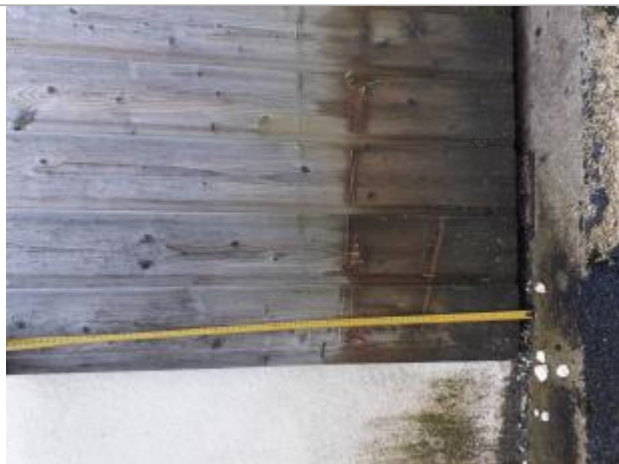
Vue de la laisse - Auteur : SPC MLA
