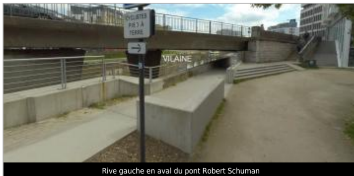
Rive gauche en aval du pont Robert Schuman
