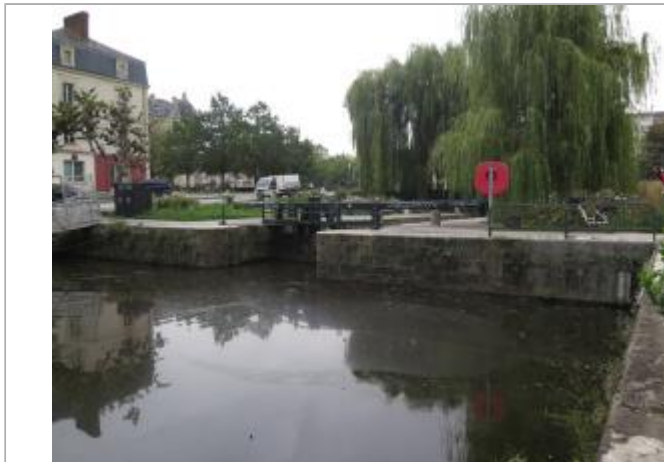
Ecluse du Mail à Rennes - échelle amont
