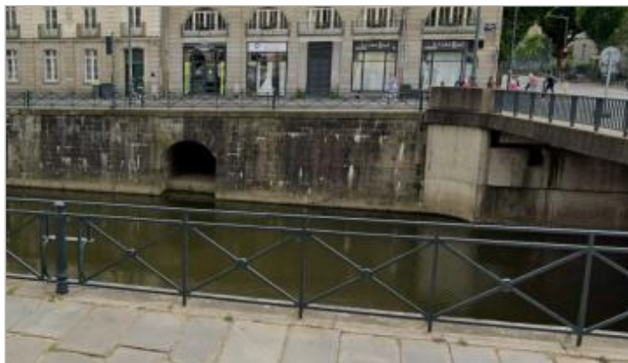
Quai Richemond au niveau du n°2 en amont du pont Pasteur
