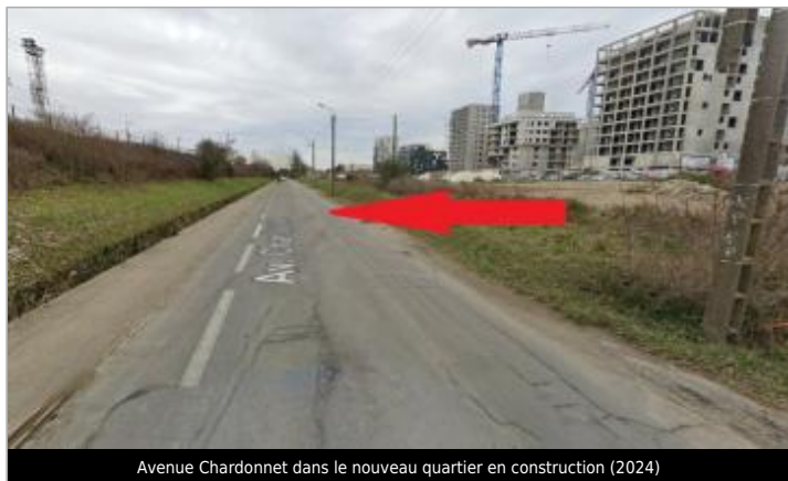
Avenue Chardonnet dans le nouveau quartier en construction (2024)
