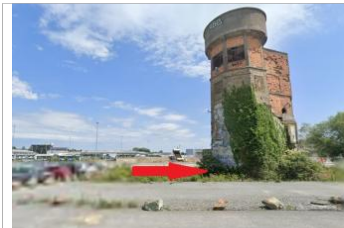
Ancien chateau d'eau Baud-Chardonnet (en ruine)
