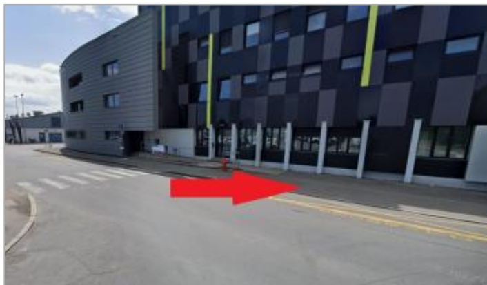
Devant de bâtiment de le Société de Transports Rennais qui n'existait pas en 1966.
