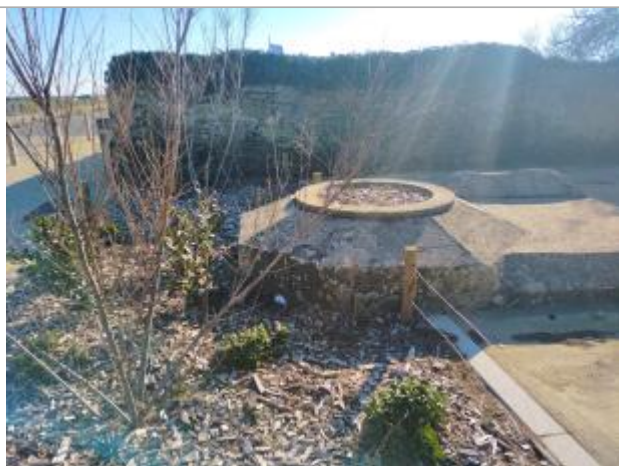
Photo du repère de submersion
