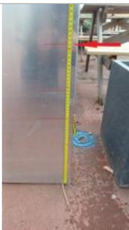
Laisse de crue à 51 cm/sol.
