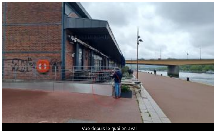
Vue depuis le quai en aval
