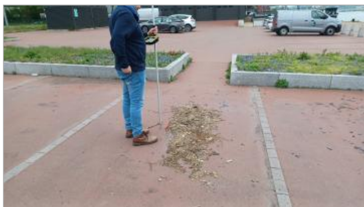
Laisse de crue au sol
