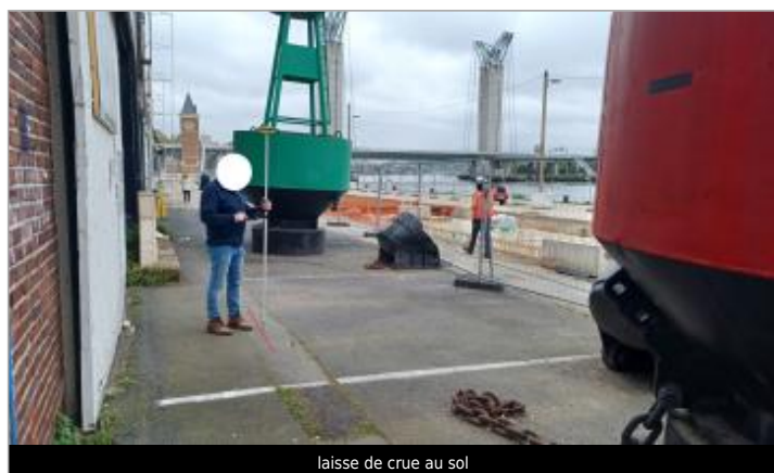
laisse de crue au sol
