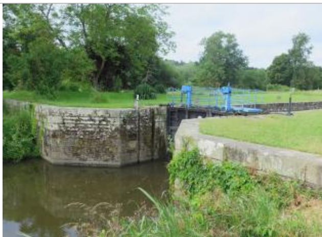
Echelle limnimétrique à l'aval de l'écluse de Pont-Réan à Bruz
