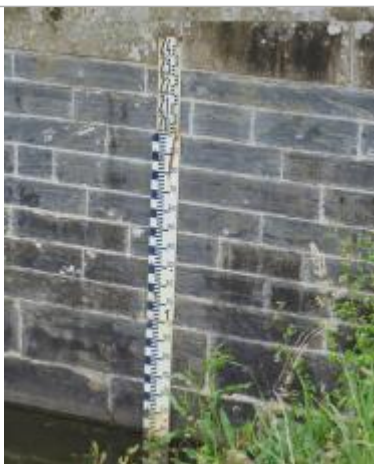
Echelle limnimétrique n°1 à l'amont de l'écluse de Pont-Réan à Bruz
