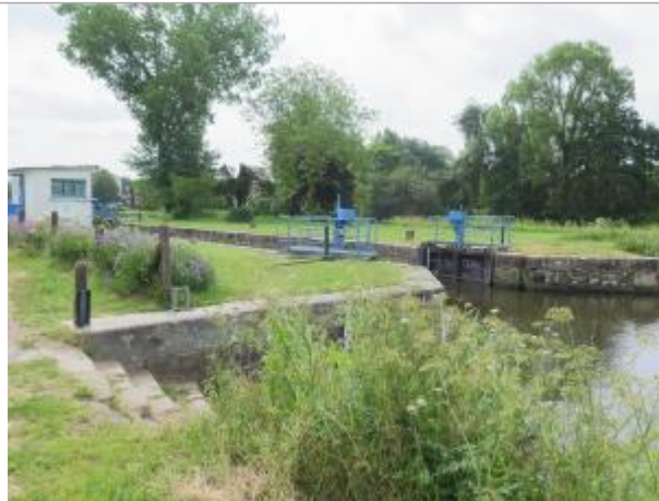
Vue générale de l'amont de l'écluse de Pont-Réan à Bruz
