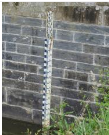
Echelle limnimétrique n°1 à l'aval de l'écluse de Mons à Bruz
