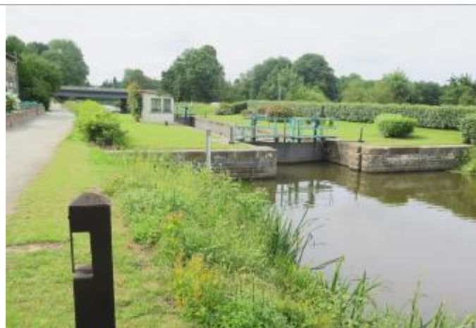
Vue générale de l'amont de l'écluse de Mons à Bruz
