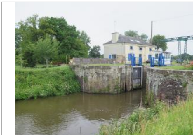
Vue générale de l'aval de l'écluse de Cicé à Bruz
