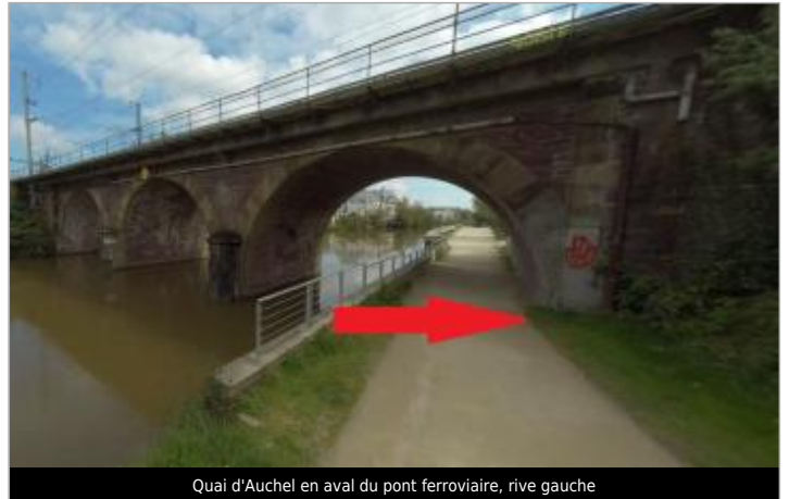
Quai d'Auchel en aval du pont ferroviaire, rive gauche
