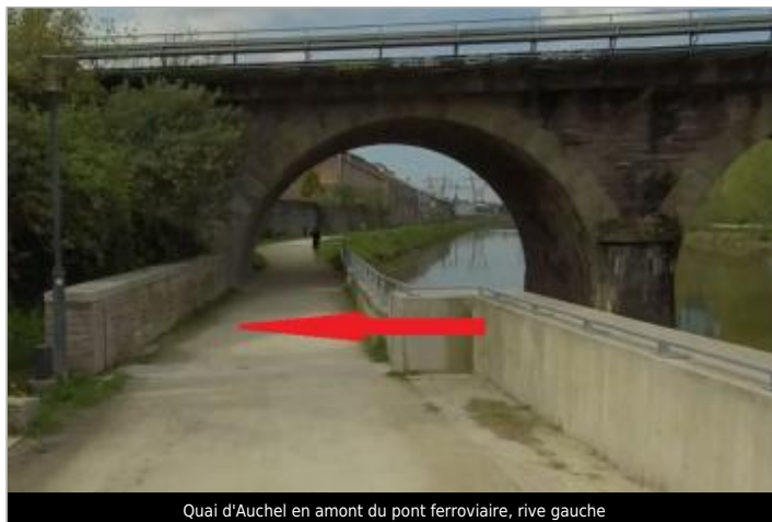
Quai d'Auchel en amont du pont ferroviaire, rive gauche
