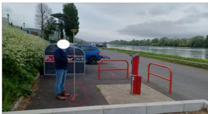
Laisse de crue de la marée de 16h00
