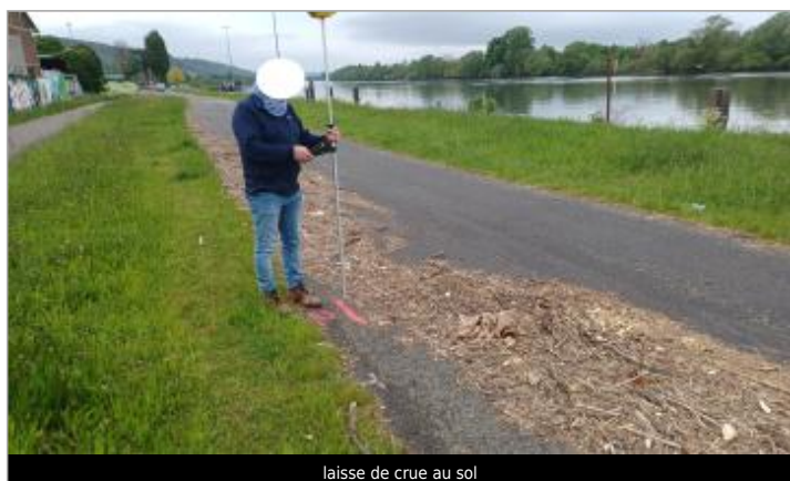
laisse de crue au sol
