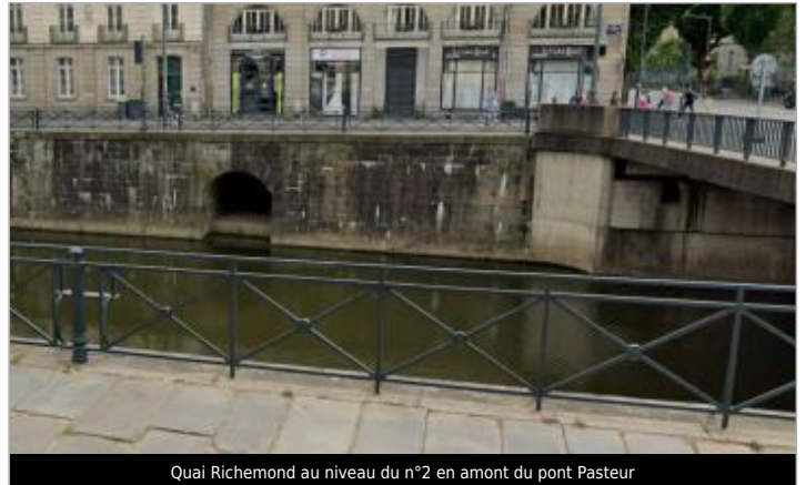
Quai Richemond au niveau du n°2 en amont du pont Pasteur
