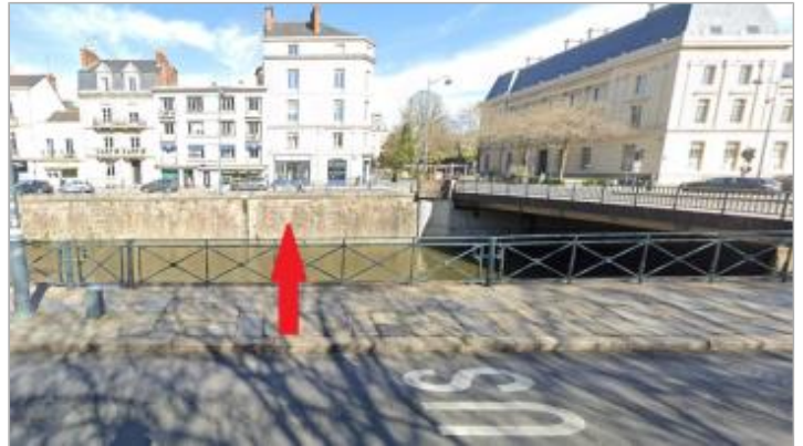
Quai Chateaubriand au niveau du n° 31-33 en aval du pont Pasteur
