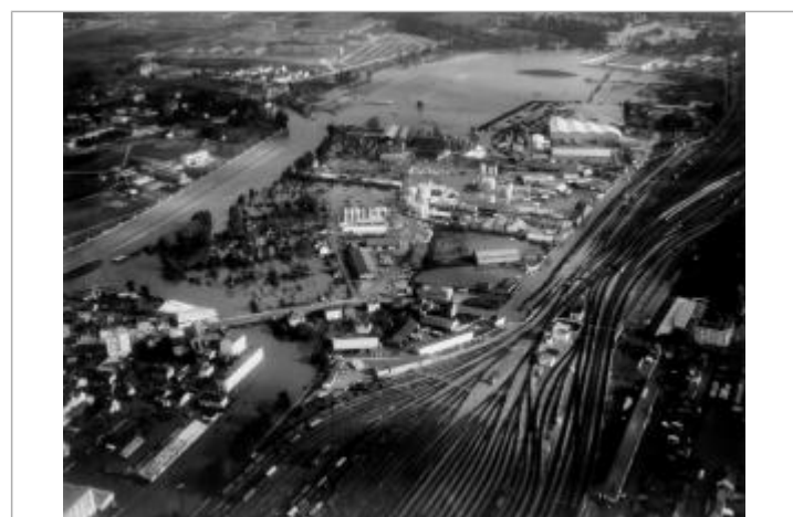
Quartier Baud-Charbonnet lors de l'inondation d'octobre 1966
