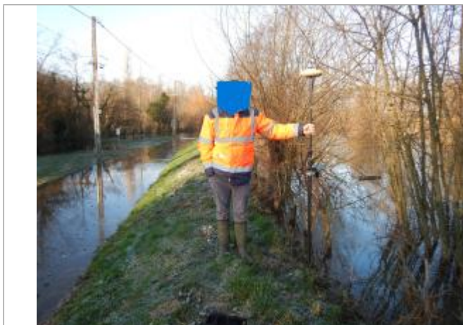
Crête de digue
