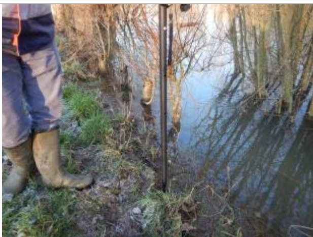
Talus droit de la digue
