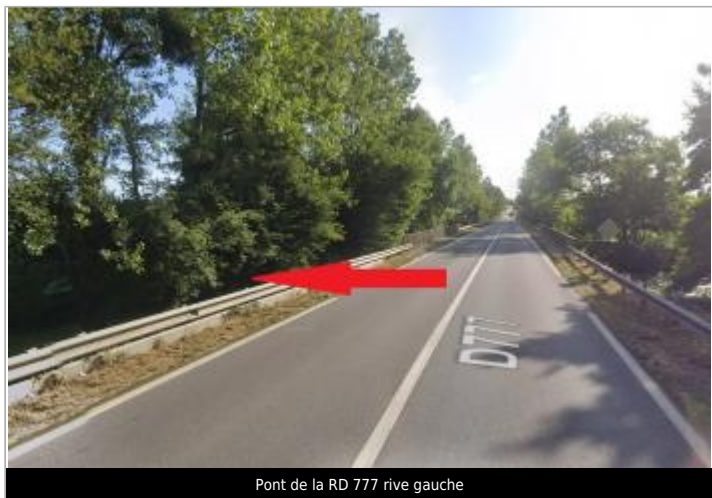
Pont de la RD 777 rive gauche
