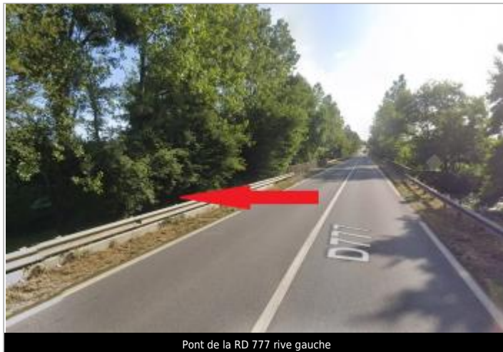
Pont de la RD 777 rive gauche
