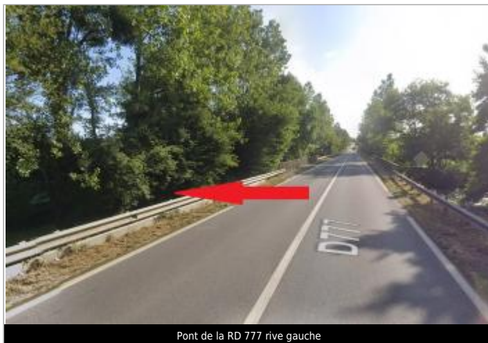
Pont de la RD 777 rive gauche
