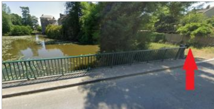
Moulin de l'Epron à Nouvoitou, bord de la RD 101
