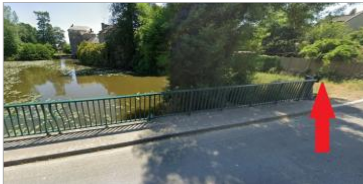
Moulin de l'Epron à Nouvoitou, bord de la RD 101
